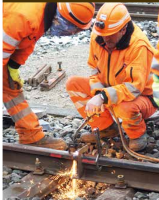
Préparation d'une opération de soudage
