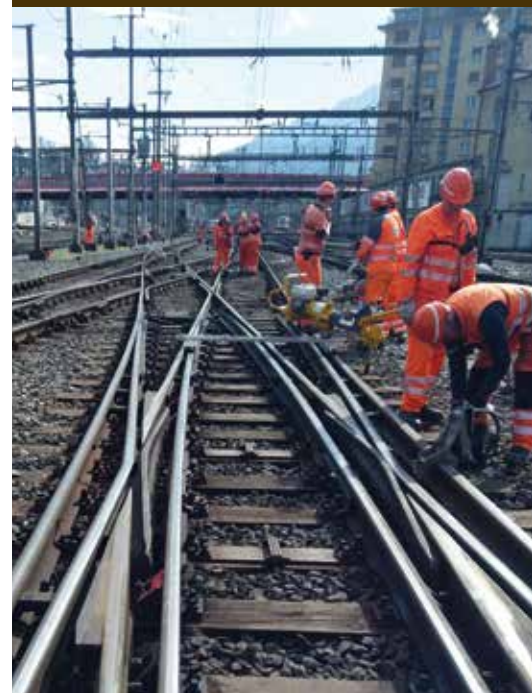
Appareil de voie du déraillement de Lucerne
