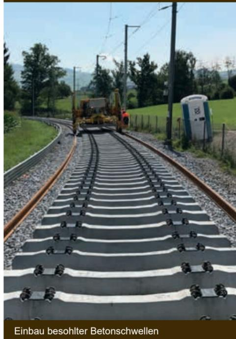
Einbau besohlter Betonschwellen
