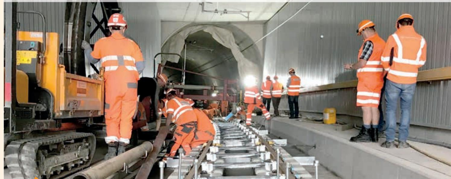
**Erstmaliger Einbau einer Festen Fahrbahn bei Appenzeller Bahnen**
