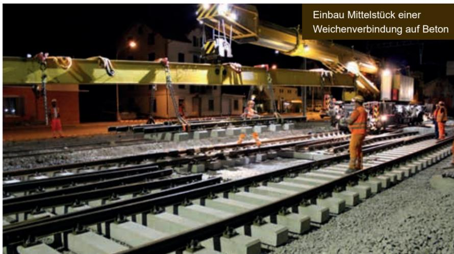
Einbau Mittelstück einer Weichenverbindung auf Beton
