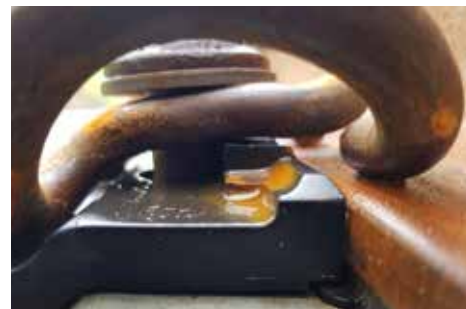
Spannklemme ungenügend vorgespannt
