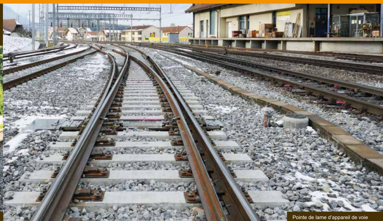
Pointe de lame d'appareil de voie
