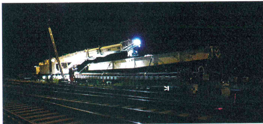
Bild 5: Weicheneinbau in Sirnach, Weiche 3, Herzstück- und Zwischenpartie, Gewicht 37 t, September 2018
